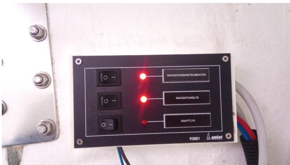
Figur 1: El-panel, hvor du kan tænde og slukke for hhv. navigationsinstrumenter, lanterne og kahytlys.
